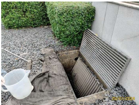
บ่อบำบัดน้ำเสียก่อนระบายออกสู่ที่ระบายน้ำสาธารณะ
